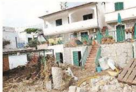
Un'immagine dei danni provocati dall'alluvione
