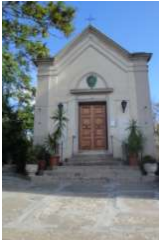
La chiesina di S. Rocco dopo il restauro.
